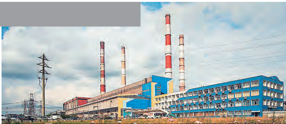
Рефтинская ГРЭС установленной мощностью 3800 МВт — самая крупная угольная электростанция в России, состоит из шести энергоблоков мощностью 300 МВт и четырех по 500 МВт. Установленная тепловая мощность — 350 Гкал/час. В качестве основного топлива использует экибастузский уголь. Вырабатывает 40% общего объема электроэнергии, потребляемой Свердловской областью
