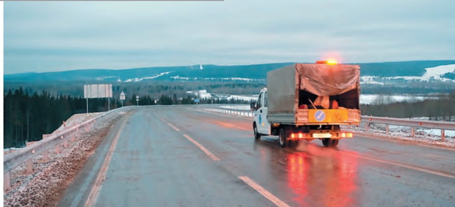
Обход Чусового является частью Северного широтного коридора — строящейся автомобильной дороги на Северном Урале и в Западной Сибири
