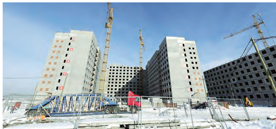
В первых двух общежитиях началась прокладка инженерных сетей, в мае строители приступят к внутренней отделке
