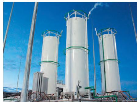
Мини-завод в д. Канюсята, Пермский край: СПГ криогенными автомобильными цистернами доставляют на терминалы регазификации, где топливо переводят из жидкого состояния в газообразное и по газопроводам доставляют потребителям
