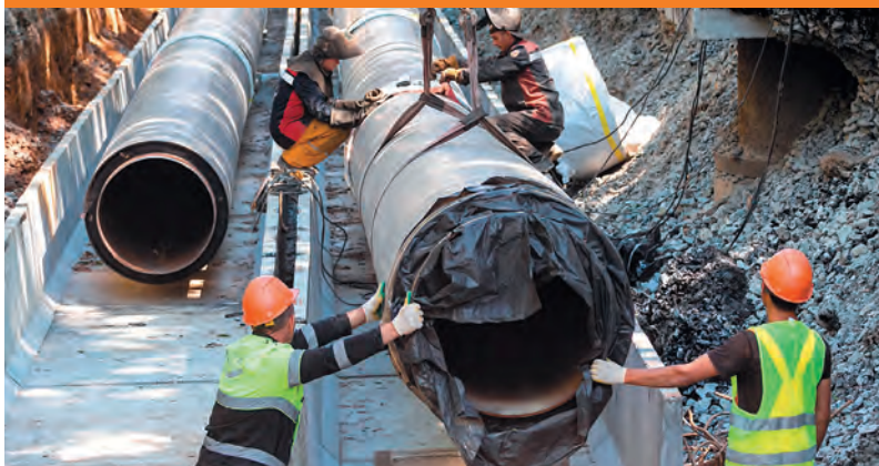
Возросшие темпы замены тепловых сетей и применение современных технологий позволили екатеринбургским теплоэнергетикам снизить повреждаемость и повысить качество снабжения потребителей теплом и горячей водой
