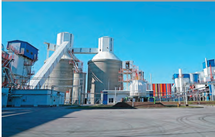
Cemix спроектирован и построен исключительно для производства белого цемента. Основными компонентами являются высококачественный известняк и каолин (белая глина)
