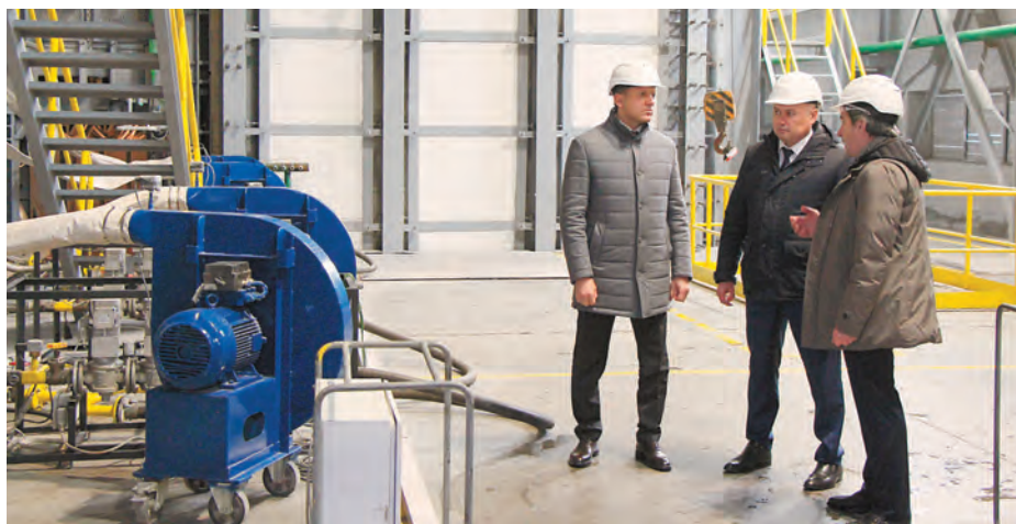
Реконструкция стекловаренной печи линии № 6 производства листового стекла началась летом 2022 года
