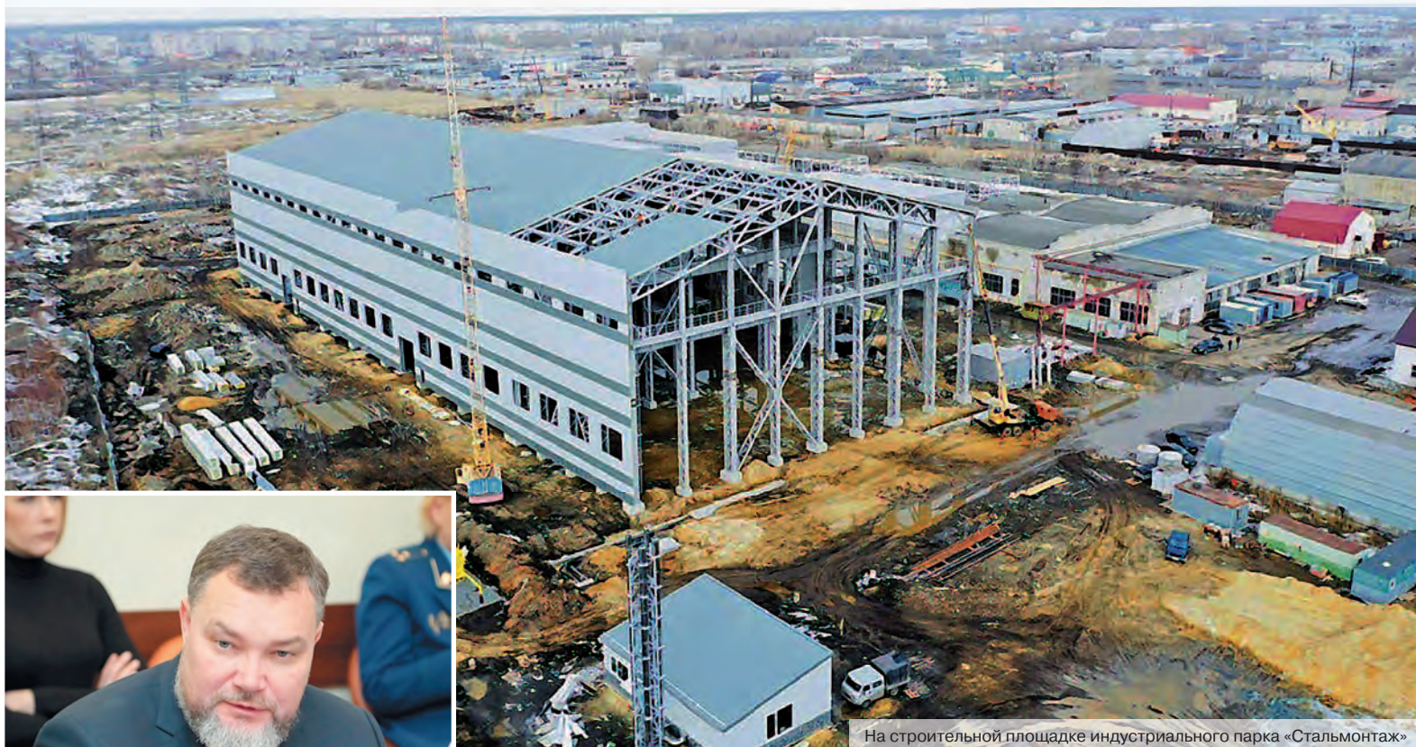
На строительной площадке индустриального парка «Стальмонтаж»
