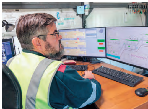
Оператор управляет работой всех насосных станций и отслеживает движение воды в них в автоматическом режиме
